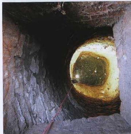
Abb. 10: Gemauertes Zugangsbauwerk, Blick in den Schacht
