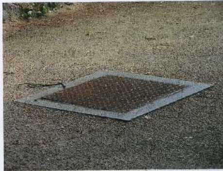
Abb. 9: Stahldeckel über dem Schacht
