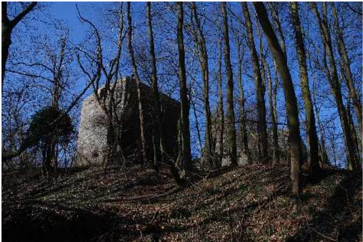
Abb. 9: Blick auf den Pulverturm im Süden der Burg.
